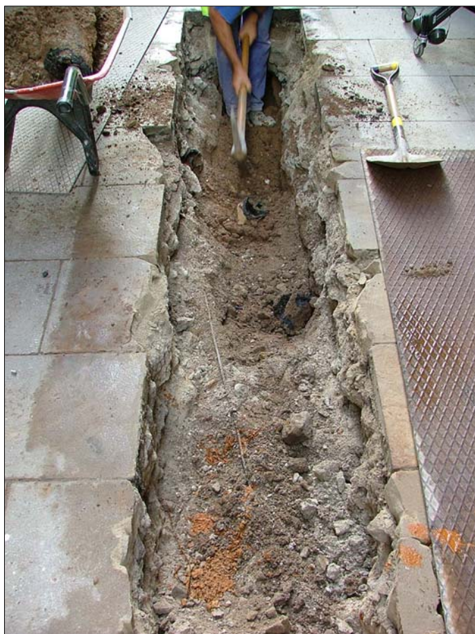
Fotografia 2: Detall de la rasa durant els treballs constructius a la Placeta de Montcada.
